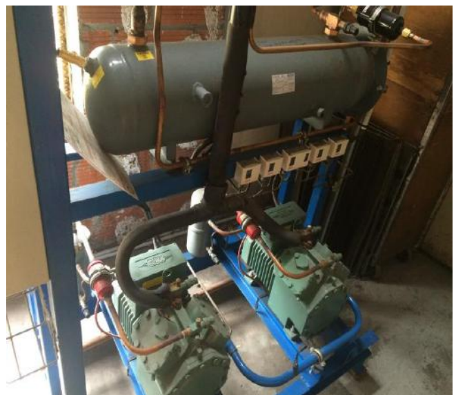
Groupes Bitzer sur réservoir chargé de 40kg de RS50
