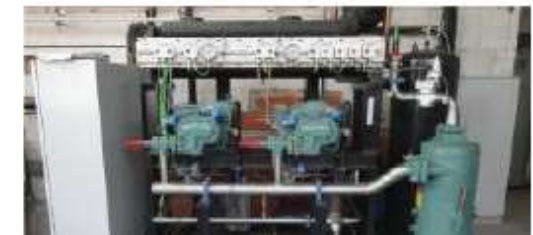
Tunnel de surgélation converti de R404 au R550 Evaporation à -35°C
