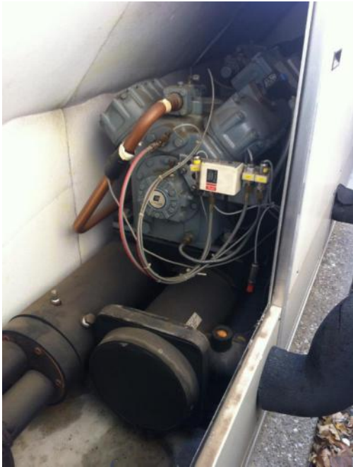
Compresseur semi-hermétique avec les échangeurs
