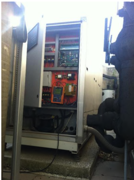
Refroidisseur avec analyseur de réseaux
